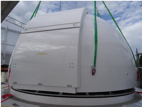
Figur 2: Abbau der alten Allsky-Kuppel.
