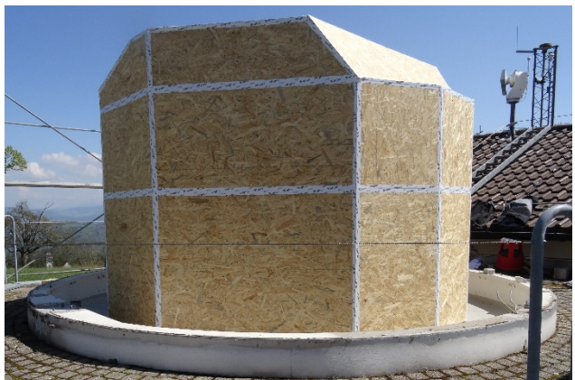
Figur 3: ZIMLAT wurde durch eine hölzerne Verkleidung geschützt.
