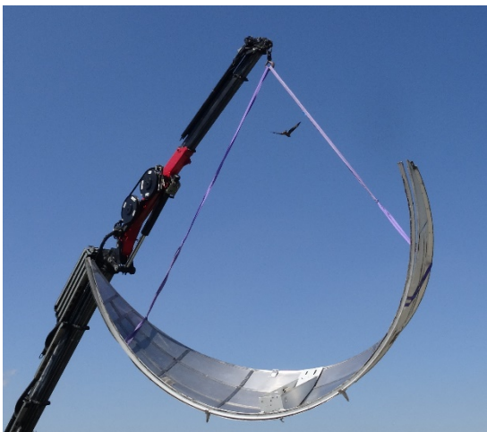
Figur 2: Abbau der alten Allsky-Kuppel.
